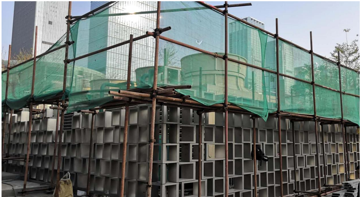
礼园不锈钢景墙部分状况
