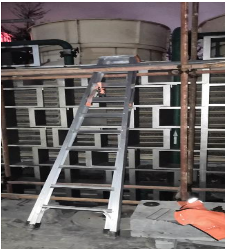
脚手架离地面高度为 2.52 米
