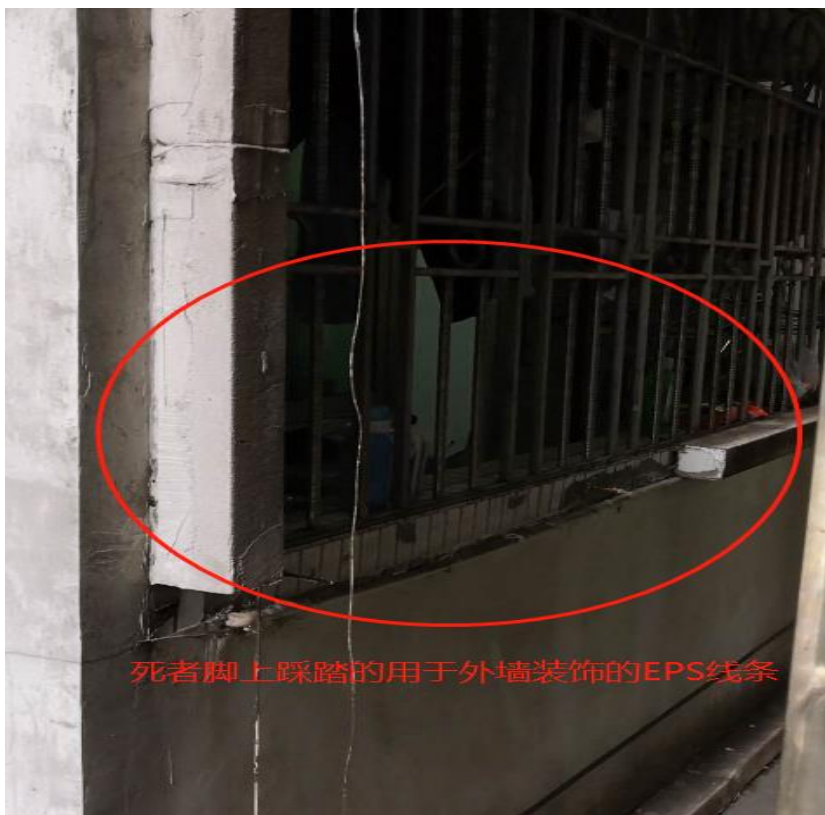
(图二) 新狮村 55 栋 B 用于外墙装饰的 EPS 线条
